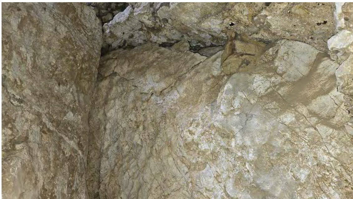
Obrázek 42: vnitřní část masivu pod objektem věže, pohled na severní vnitřní stěnu, jedná se o odlučnou oblast předchozího staršího uvolnění bloku, na snímku je zřejmá přímé základová linie obvodového zdiva věže
