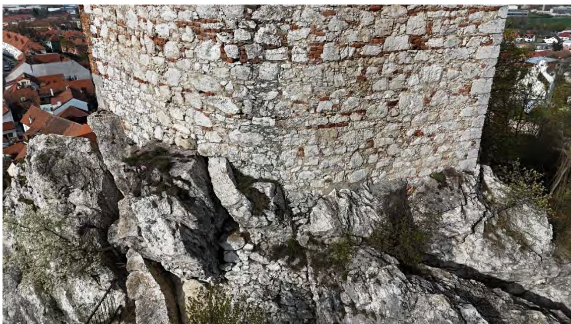
Obrázek 39: horní partie masivu v sektoru VĚŽ, který tvoří základové podloží pro obvodové nosné zdivo bývalé dělostřelecké věže, je možné sledovat velmi proměnný charakter bloků a jejich vzájemnou pozici a také předchozí postupy při stabilizaci masivu vyzdívkami.
