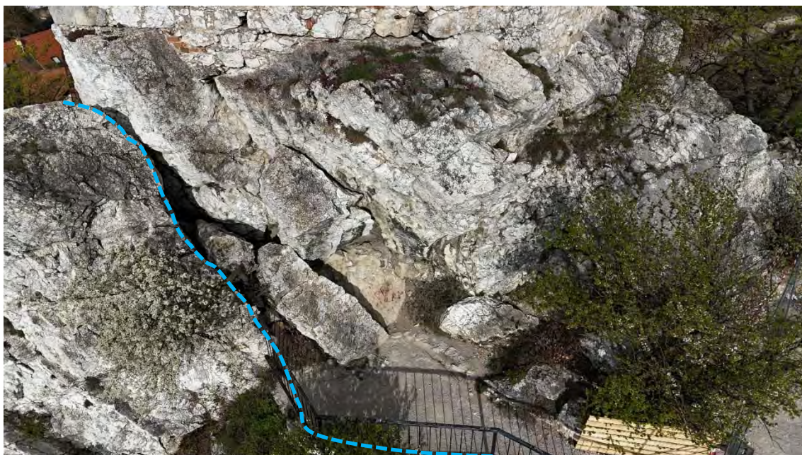
Obrázek 38: pohled na hlavní poruchu struktury bradlového masivu pod objektem věže, linií je vyznačeno rozdělení sektoru VÝCHOD a VĚŽ,
