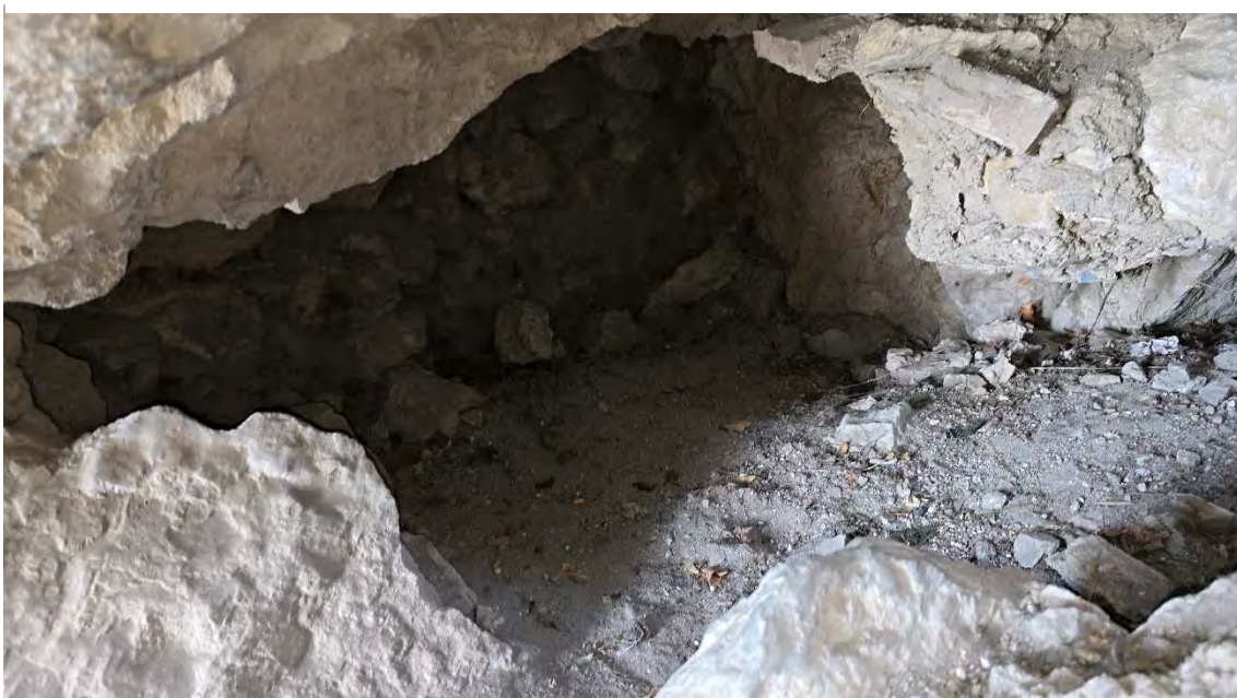
Obrázek 44: detail starší stabilizační vyzdívky masivu, východní stěna
