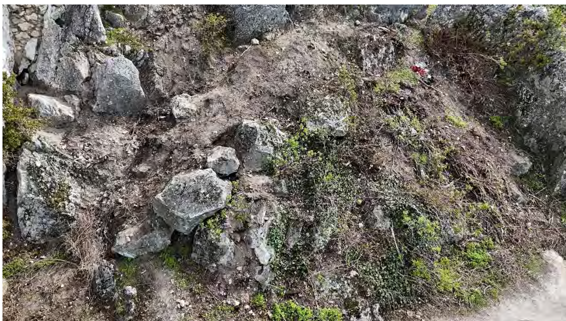
Obrázek 20: celkový pohled na centrální partie sektoru JIH s hlinito kamenitými navážkami, kde se předpokládá revitalizace odstraněním a nahrazením vhodné zeminy a náhradní výsadbou
