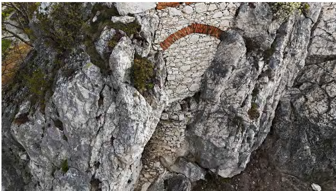
Obrázek 23: celkový pohled na vyzdívku masivu jižní stěny objektu Kozího hrádku, je možné sledovat strukturní systém diskontinuit masivu
