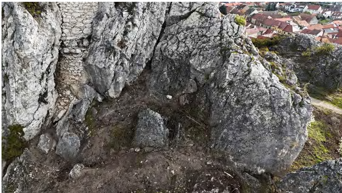
Obrázek 19: pohled na hlavní parte sektoru JIH, vlevo masiv s výplní původní vyzdívky masivu, na pravé straně možné vidět masivní břit oddělující sektory JIH a VÝCHOD. Mezi bloky je zastíženo souvrství hlinito kamenitých navážek
