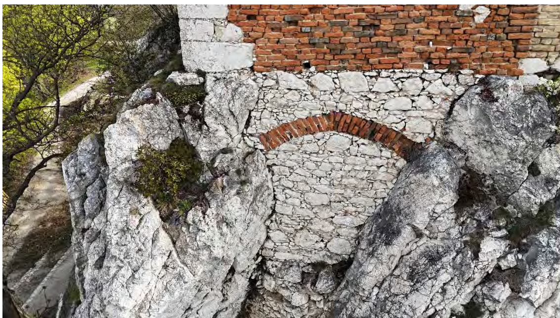
Obrázek 24: pohled na vyzdívku hlavní strukturní poruchy masivu, vyzdívkou vyplněná porucha je průběžná k severní straně – ke vstupu do objektu
