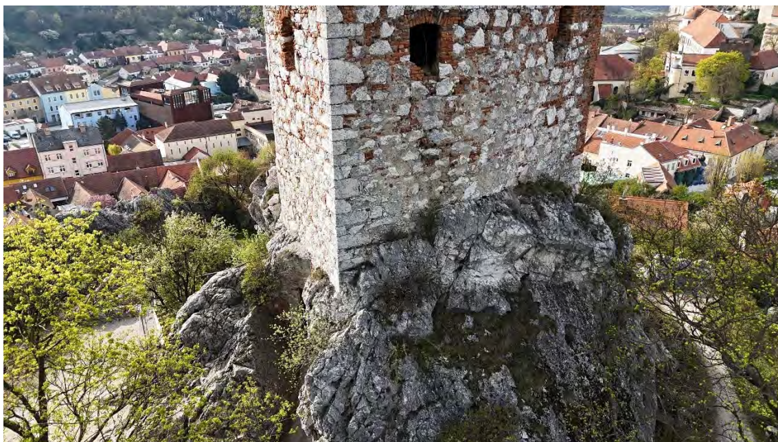
Obrázek 10: pohled na založení objektu věže na skalní masivu
