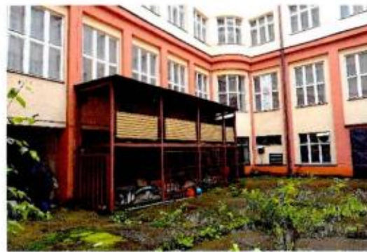
přístřešek na nádvoří
