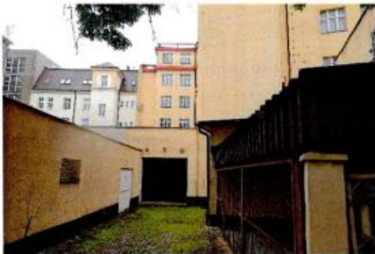
garáže a přístřešek na popelnice
