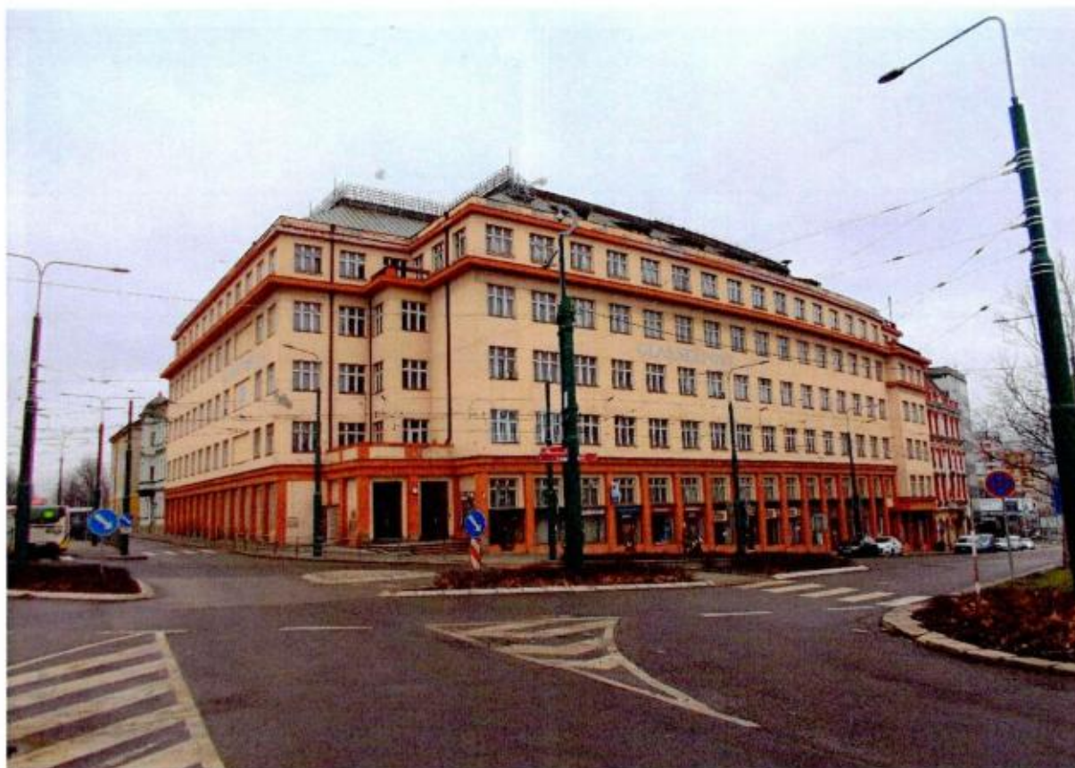
celkový pohled z jihu z ul. Žitavské na křižovatku s tř. 1.máje
