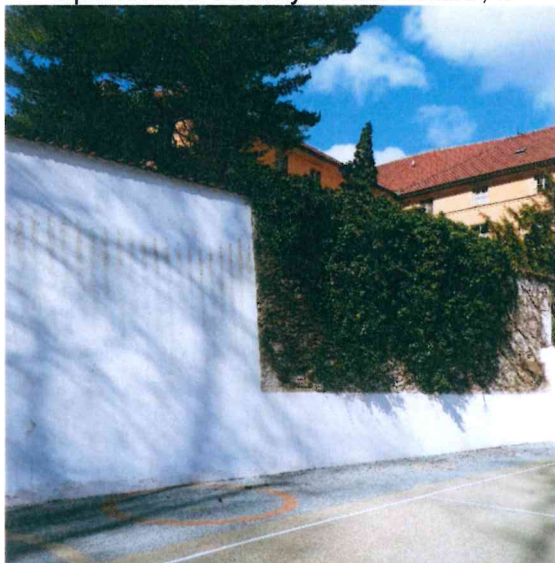
Opěrná zeď Janský Vršek úsek 7, 8
