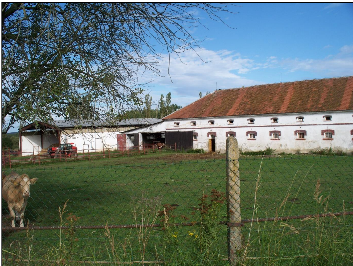
1. Jižní pohled 1 (budova skladu vlevo je na pozemku p. č. -66)
