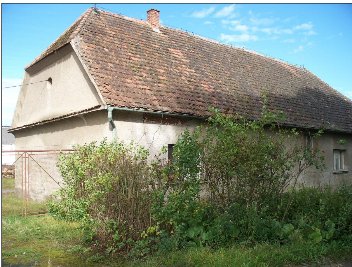
4. Západní pohled 2 (administrativní budova)
