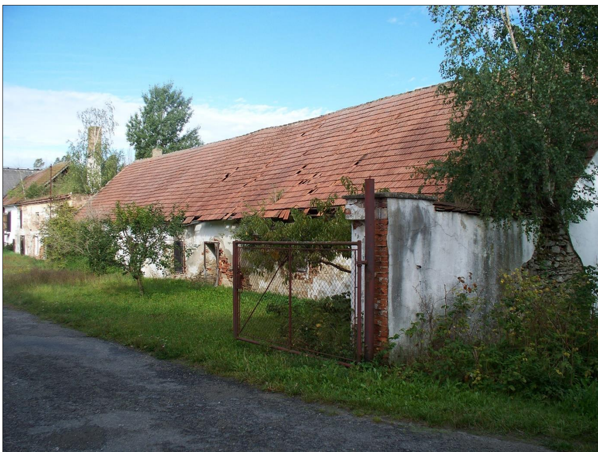
6. Západní pohled 3 – vjezd do dvora + nevyužívané stavení
