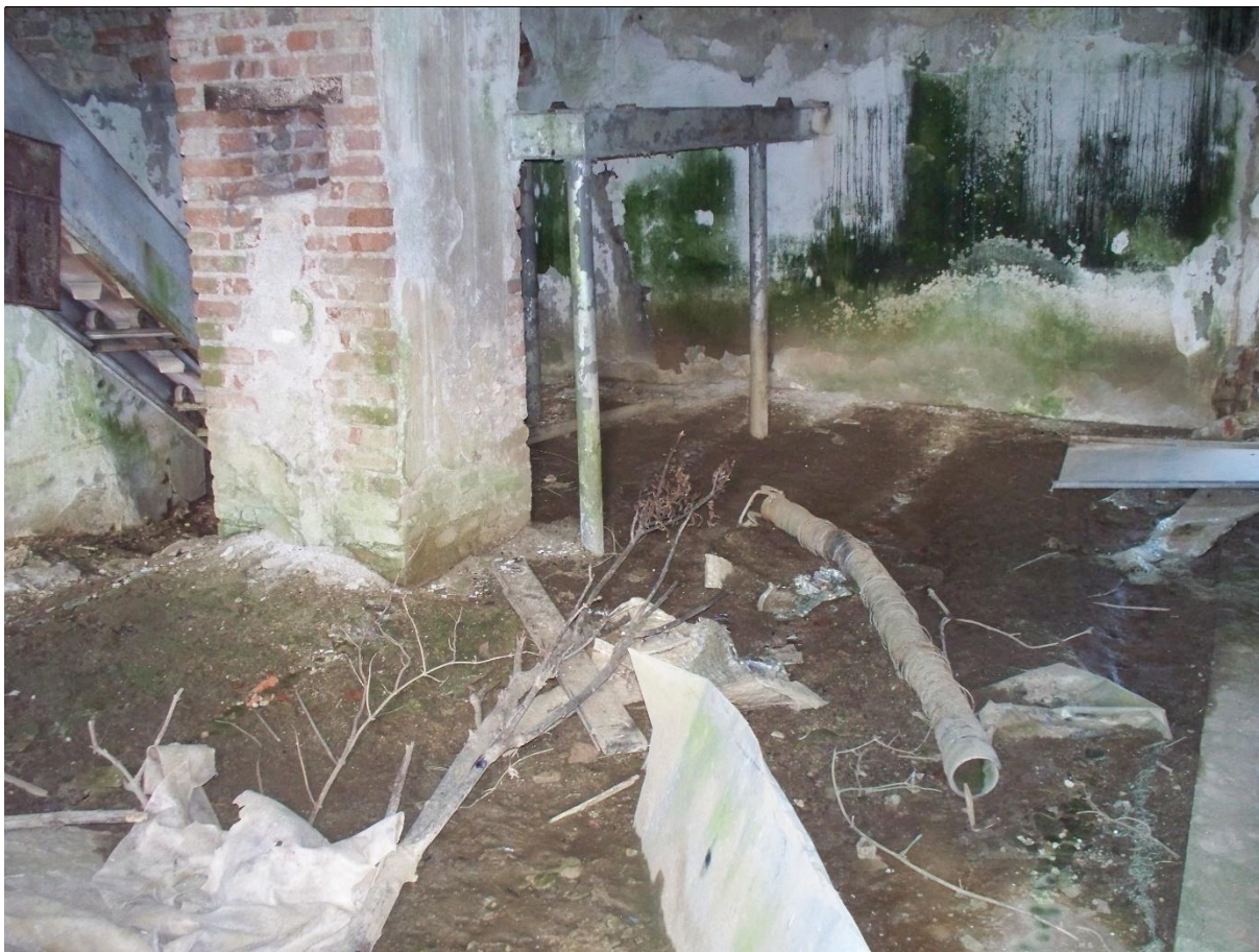
9. Vnitřní pohled do objektu
